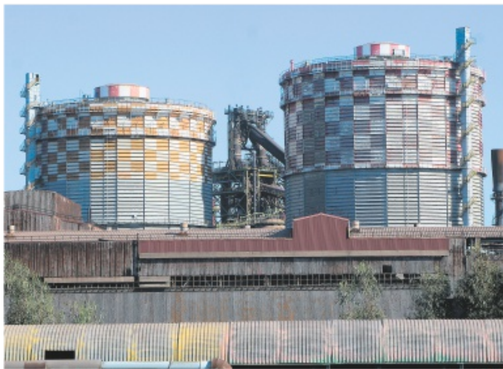
PRODUZIONE AL CONTAGOCCE Un particolare degli impianti dell'ex Ilva di Taranto
